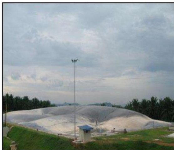
Figura 4.15 - Cobertura das lagoas anaeróbicas por uma geo-membrana de polietileno. Fonte: NKEA(2011).
